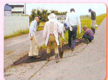
道路補修作業
