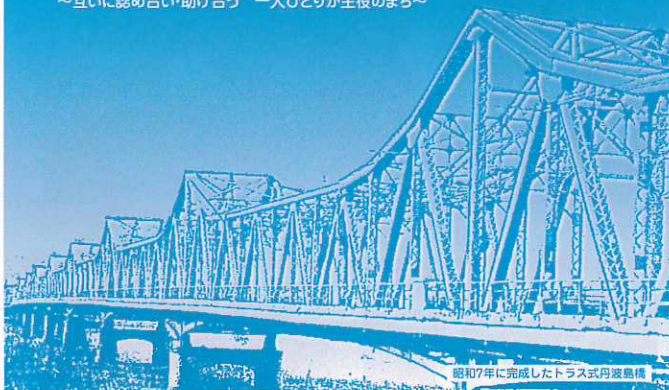
昭和7年に完成したトラス式丹波島橋
